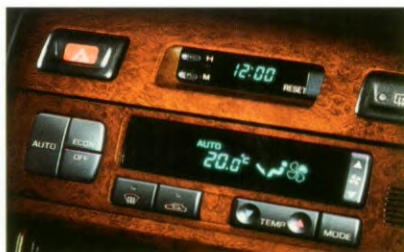
Airconditioning met automatische temperatuurregeling.
