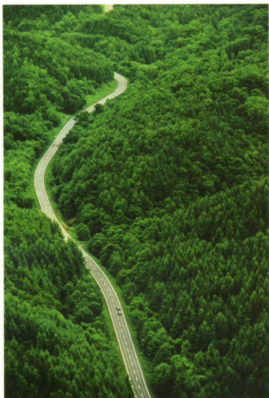
Testbaan met hi-tech faciliteiten.
