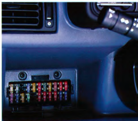
De zekeringen zijn gemakkelijk bereikbaar.
