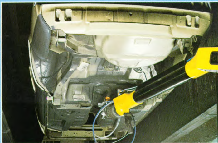
Volledige coating van de onderkant met kunststof.
